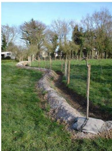
L'eau capturée par la baissière peut être conservée quelques heures voire quelques jours jusqu'à son infiltration totale. Lorsque la baissière arrive à saturation, « une voie de débordement » servira à évacuer le surplus d'eau évitant ainsi le débordement et l'érosion rapide de la butte.
